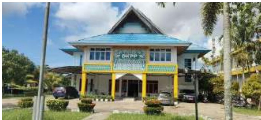
Gambar 1.2 Kondisi Gedung Dinas Ketahanan Pangan dan Perikanan Kabupaten Ketapang Tahun 2024
