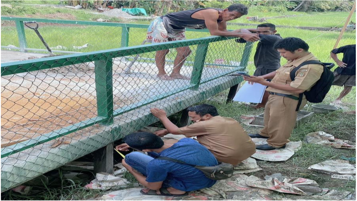
Pembangunan Infrastruktur Lantai Jemur
