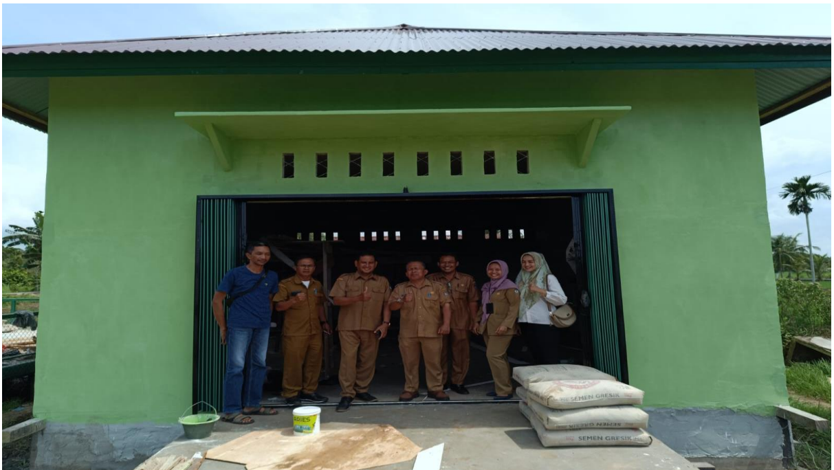
Pembangunan Infrastruktur Lumbung Pangan
