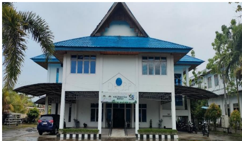
Gambar 1.2 Kondisi Gedung Dinas Ketahanan Pangan dan Perikanan Kabupaten Ketapang Tahun 2021
